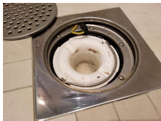
Tettesjiktets tilslutning til sluk - Sluk
