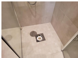
Tettesjiktets tilslutning til sluk - Sluk
