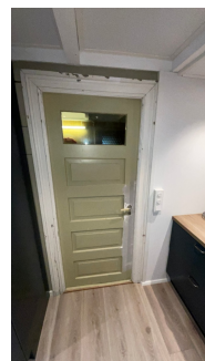
Dør mellom kjøkken og gang. Er delvis sparklet
