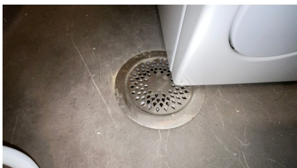
Sluk med skrudd slukrist og skrudd klemring
