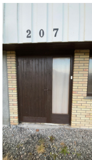
Hoveddør. Mangler beslag under dør
