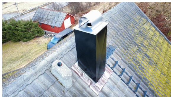
Pipehatt, luftehatt og takstige
