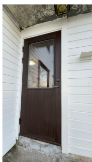
Hoveddør. Mangler beslag under dør
