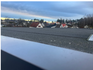
Taktekket besiktiget fra takfot.
