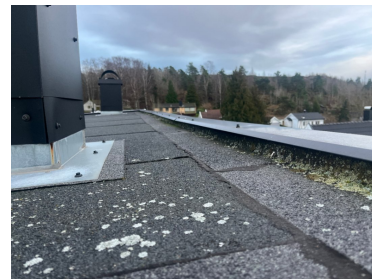
Taktekket besiktiget fra takfot.
