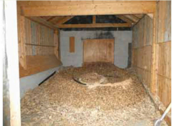
Flislager, med teknisk utstyr mating
