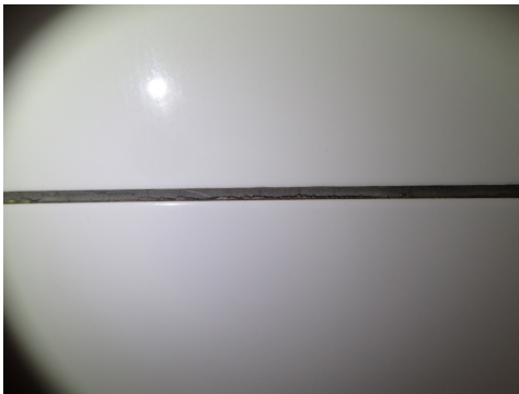
Eksempel på riss i fuger
