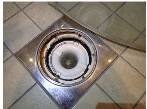
Sluk på bad/vaskerom
