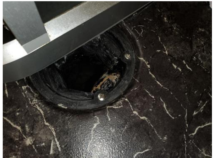
Våtrom - [Sluk bad]
