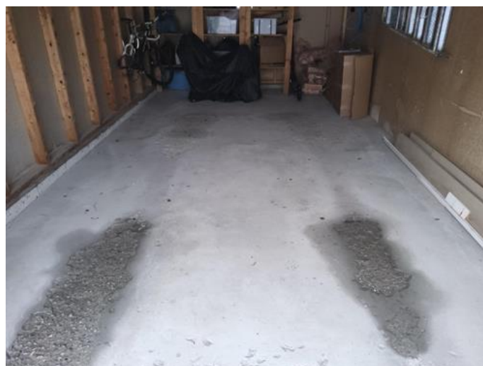
Overflater gulv - [Gulv i garasje.]
