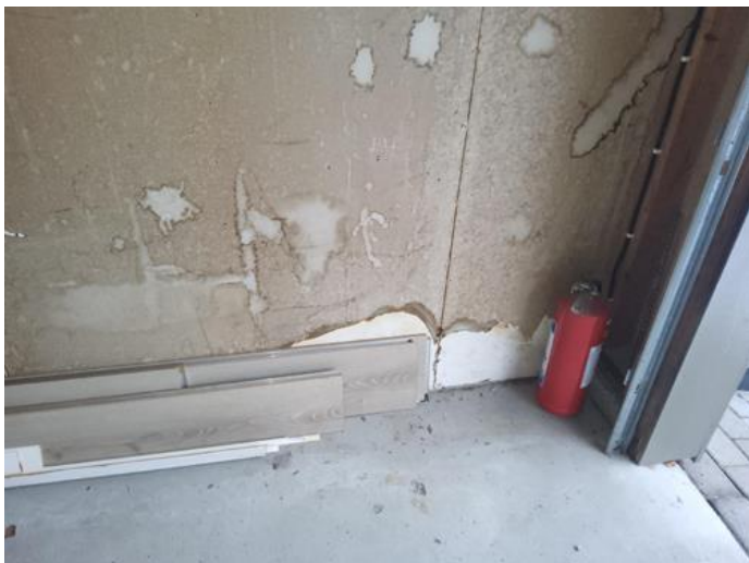
Overflater vegger - [Eksempel på fuktmerker på vegger i garasje. ]
