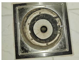
Tettesjiktets tilslutning til sluk - Sluk bad
