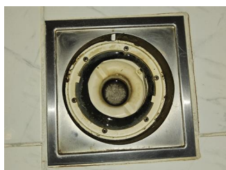
Tettesjiktets tilslutning til sluk - Sluk dusj
