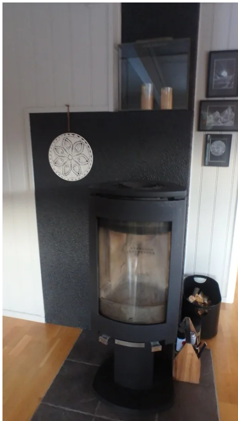
Vedovn på stue i første etasje.
