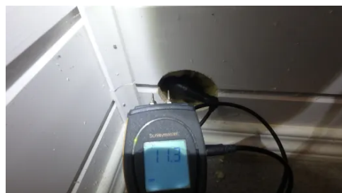
Fuktmåling i vegg fra bod.
