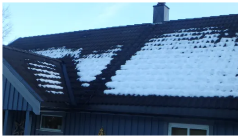
Takstige for adkomst til skorstein.
