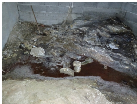
Fjellgrunn sett fra nordøstre kryprom
