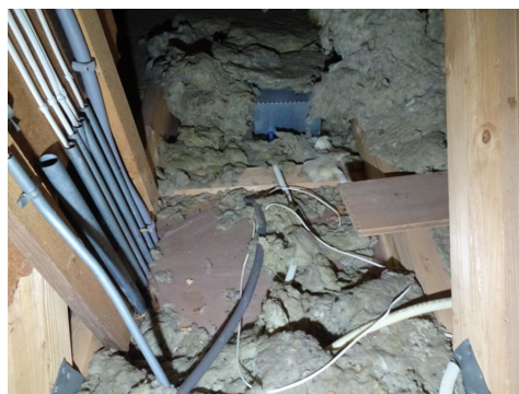
Rydde i isolasjon, isolere bedre rundt spotkasse
