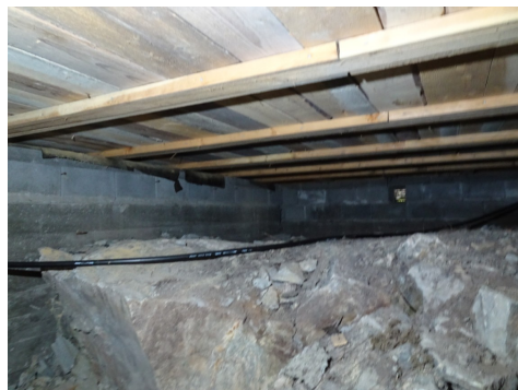
Fjellgrunn sett fra sørvestre kryprom
