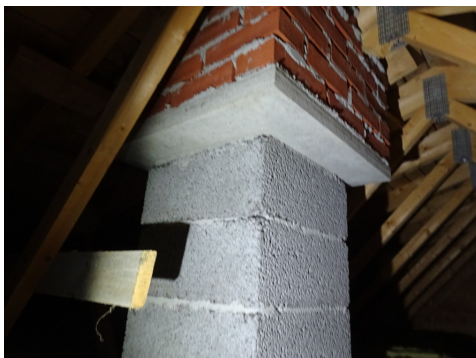
leca pipe 1984 med teglstein fra loft til over tak
