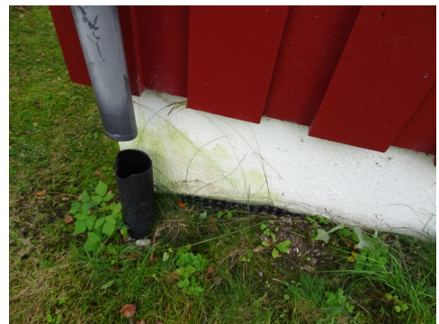
mottaksrør er tett
