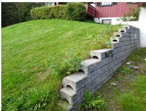
Terrengmur på sørøstre side
