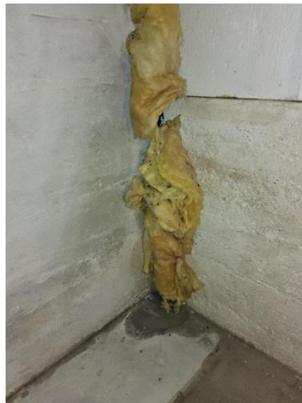
Rom under terreng (kjeller, underetasje, sokkeletasje) - [Spor etter gnagere U.etg. ]
