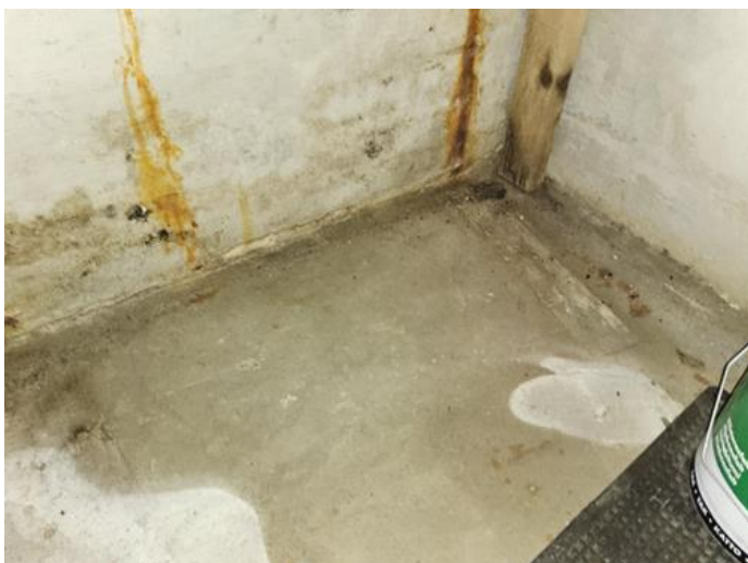
Rom under terreng (kjeller, underetasje, sokkeletasje) - [Fuktmerker U.etg. ]
