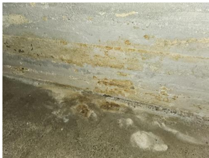
Rom under terreng (kjeller, underetasje, sokkeletasje) - [Soppvekster U.etg. ]
