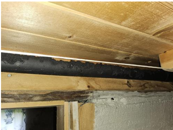
Rom under terreng (kjeller, underetasje, sokkeletasje) - [Skader etter gnagere U.etg. ]
