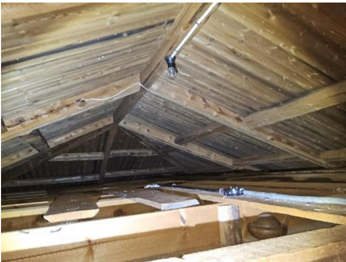
Loft - uinnredet / råloft - [Kaldtloft ]
