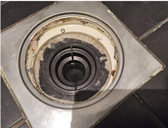
Våtrom - [Sluk på bad.]
