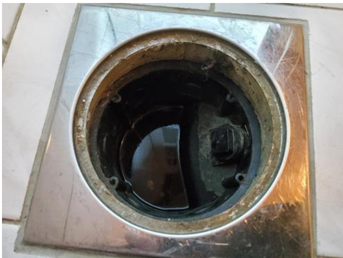
Membran, tettesjikt og overgang til sluk. - [Sluk i bad 1. etg. enebolig]
