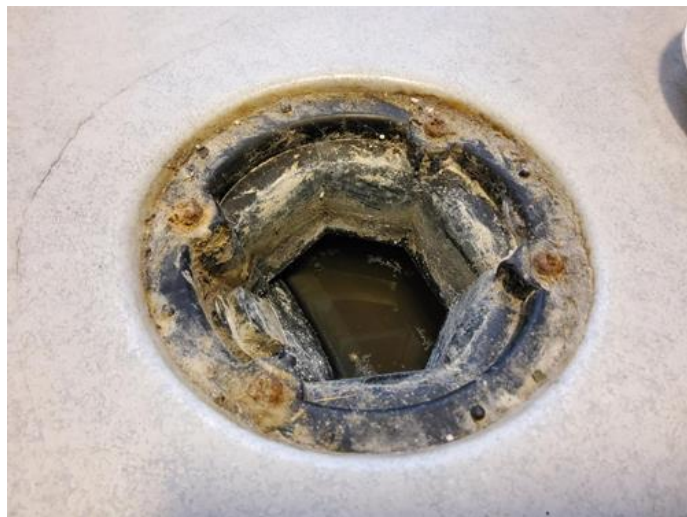
Membran, tettesjikt og overgang til sluk. - [Sluk i vaskerom enebolig]
