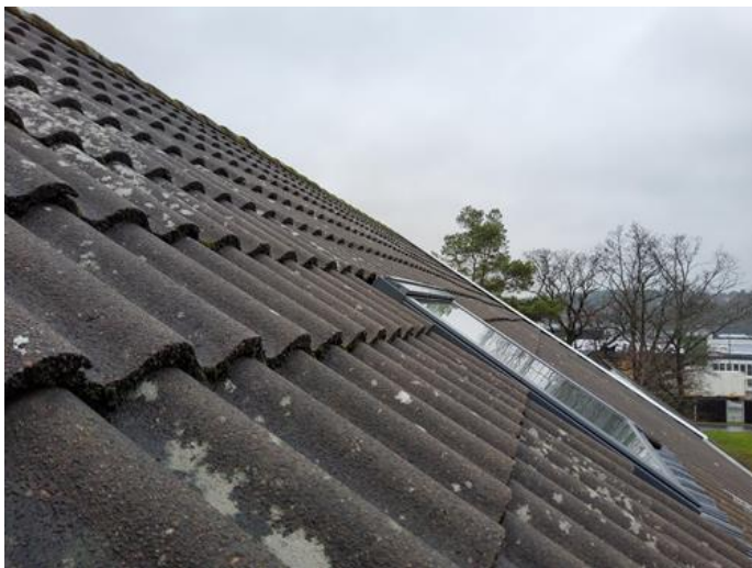
Yttertak - [Taktekking enebolig. ]
