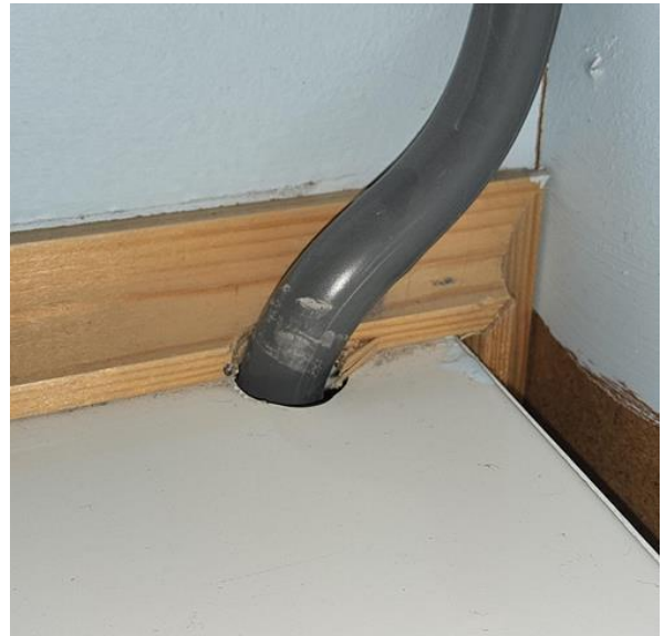
Forenklet vurdering av det elektriske anlegget - [Åpning i sikringsskap]
