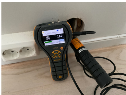
Fuktmåling i vegg ved hulltaking.
