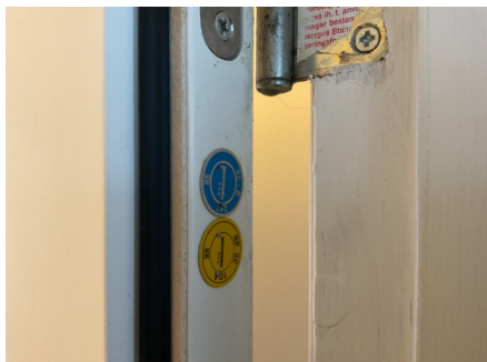
Inngangsdør med brann og lydklassifisering b 30 og 35 db.
