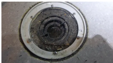
Sluk av plast type med synlig klemt belegg (membran).
