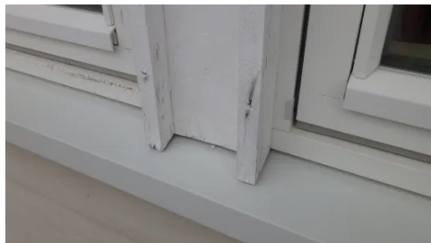
Slitasje i overflater vinduer.
