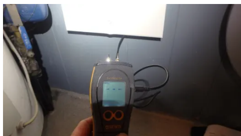
Fuktmåling er utført i vegg mellom vaskerom og bad, ingen tegn til fukt.
