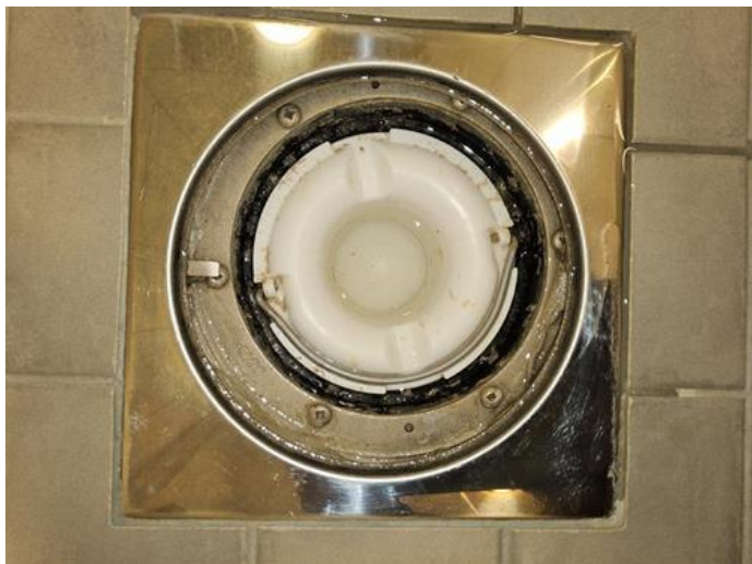
Våtrom - [Sluk bad.]
