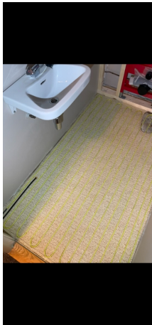
Skjema: "NHO Brannforebyggende elk kontroll NEK405-2:2020: Tordis vei 7A" Beskrivelse: Varmekabel wc underetasje 2, Filnavn: IMG_26251.png
