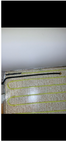
Skjema: "NHO Brannforebyggende elk kontroll NEK405-2:2020: Tordis vei 7A" Beskrivelse: Varmekabel wc underetasje 2, Filnavn: IMG_26251.png
