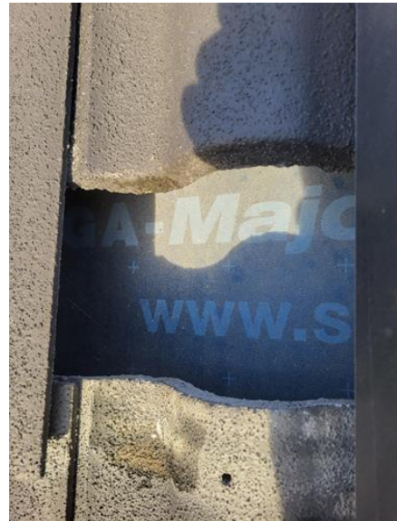
Utvendig - [Yttertak, pustene undertak]
