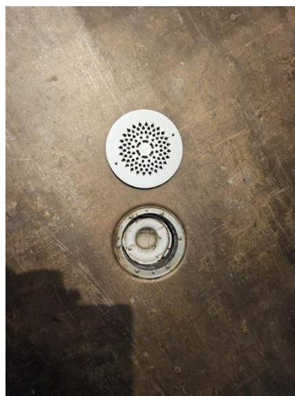
Våtrom - [Sluk på bad 2. etasje]
