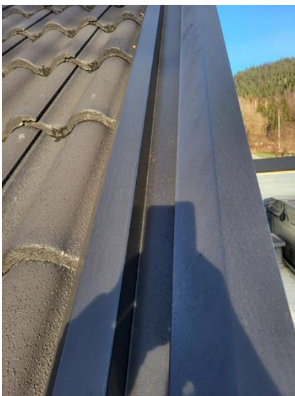
Utvendig - [Yttertak, stedvise skottrenner mot vindskier]
