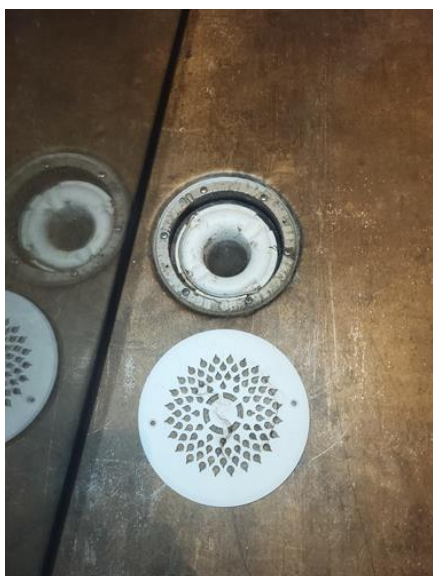
Våtrom - [Sluk på bad 1. etasje]
