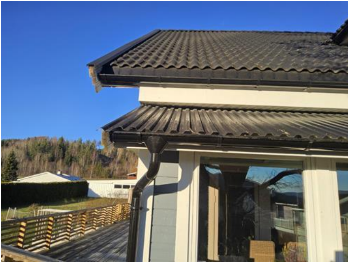
Utvendig - [Yttertak, blikktak til utestue]
