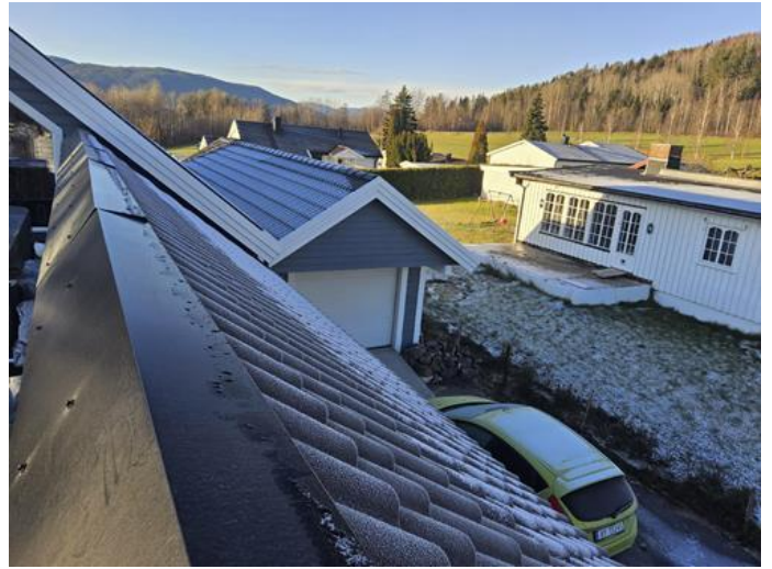
Utvendig - [Tak over kott/bod på takterrasse]
