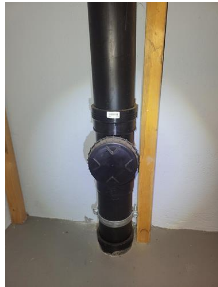
Tekniske anlegg, VVS anlegg (Sjekkpunkter utover det som er inkludert i andre rom) - [Stakepunkt]
