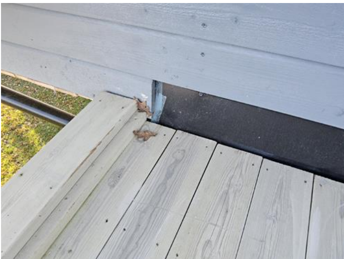
Utvendig - [Overgang inn på vegg fra takterrasse]
