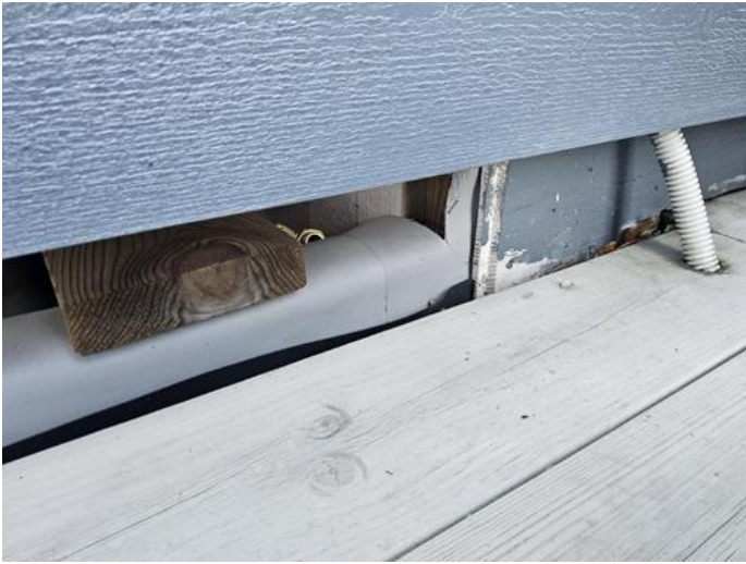
Utvendig - [Overgang sarnafil membran ]
