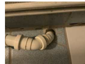
Rør rett gjennom gulv med slipp i silikon
