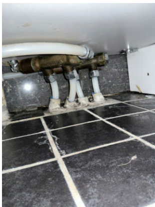
Gjennomføringer i gulv under innredning.
