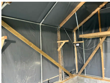
Garasje er oppført i trekonstruksjoner over plastgarasje.
