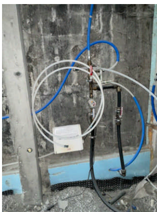
Røropplegg ligger åpent i garasje ved leilighet i sokkel.
