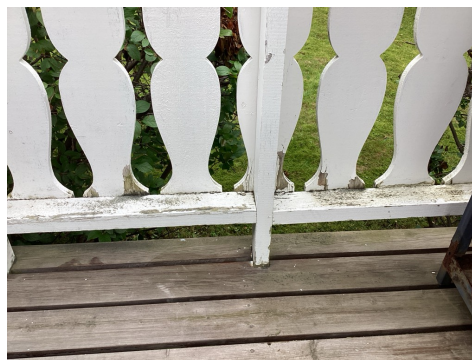
Manglede vedlikehold på rekkverk
