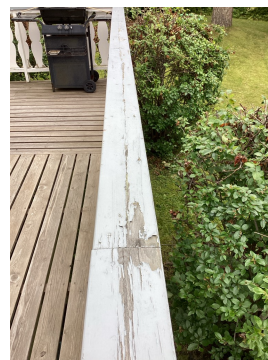
Manglede vedlikehold på rekkverk
