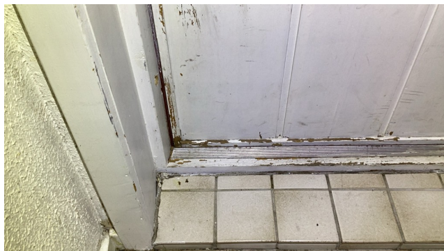
Ytterdør til leilighet er mye skadet i nedkant.
