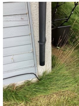
Lav høyde fra terrenget til kledningen.
