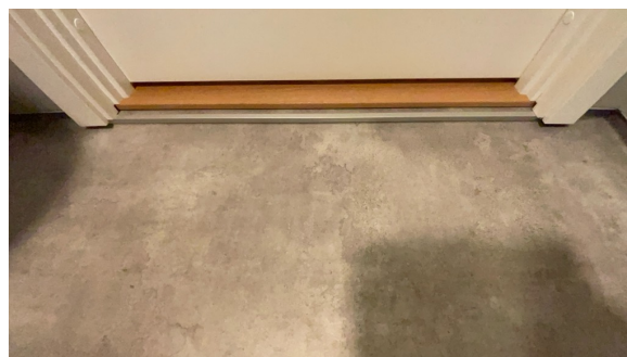
Belegg er ført opp og sikret med kant mot dør
