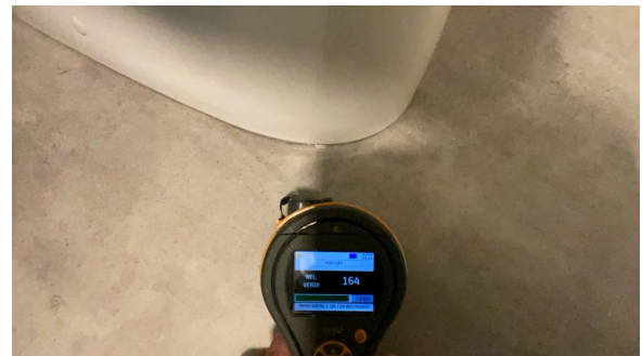
Fuktsøk er utført på gulv ved toalett/dør. Ingen forhøyde fuktavvik er målt
