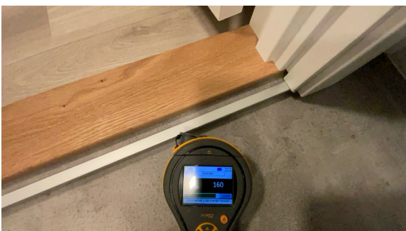
Fuktsøk er utført på gulv ved dør. Ingen forhøyde fuktavvik er målt
