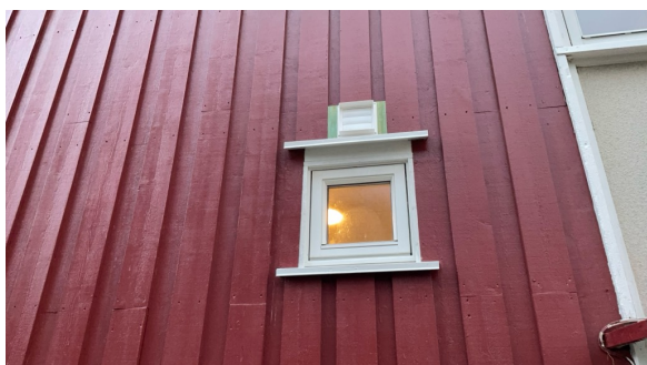
Vindu på bad
