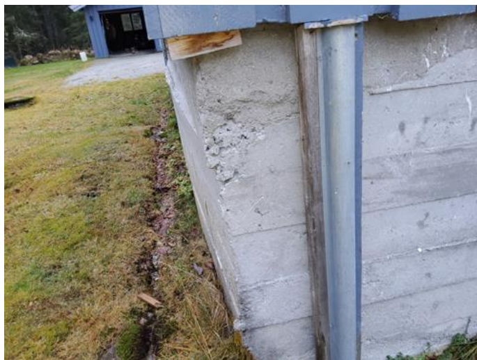
Grunnmur - [Skjevheter]
