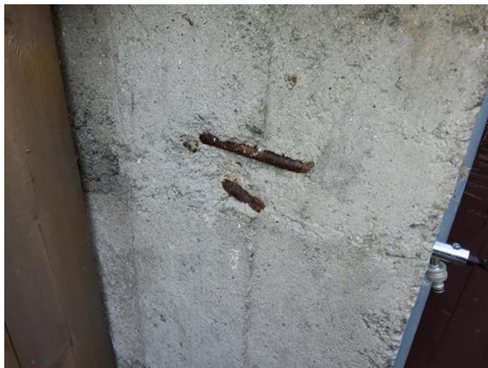
Beskrivelse - [Eksponert armering- Grunnmur]
