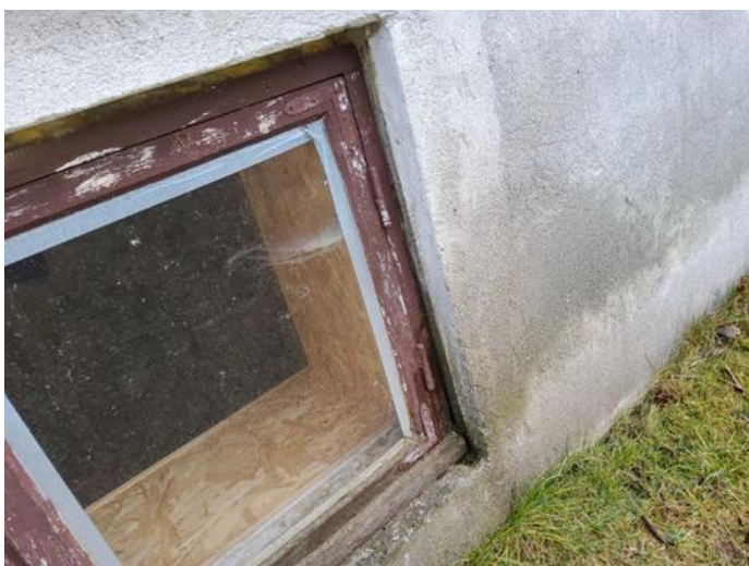
Annet - [Åpninger/utettheter rundt kjellervindu]
