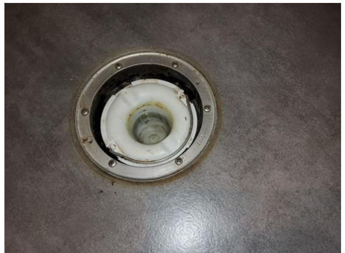
Våtrom - [Sluk bad]
