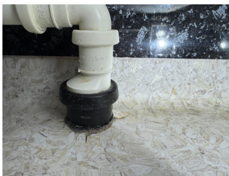
Eksempel på utetthet
