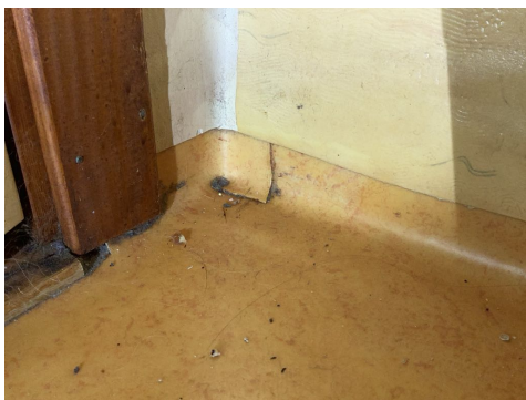
Eksempel på ikke fagmessig utførelse av hjørner.
