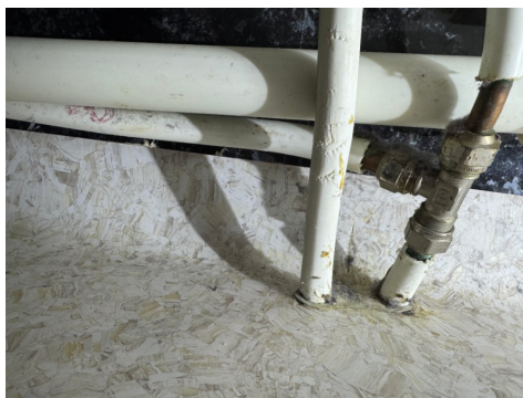
Eksempel på utetthet
