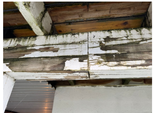
Ufagmessig skjøt av bærebjelke
