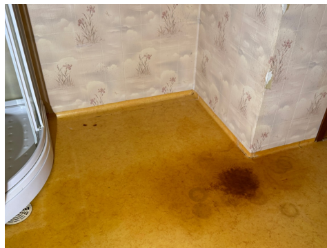
Varmeskadet belegg
