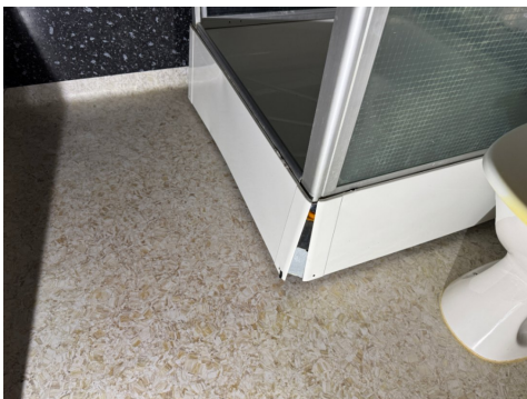
Defekt/skadet duskabinett
