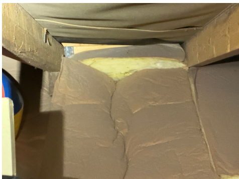
Eksempel på manglende lufting ved raft
