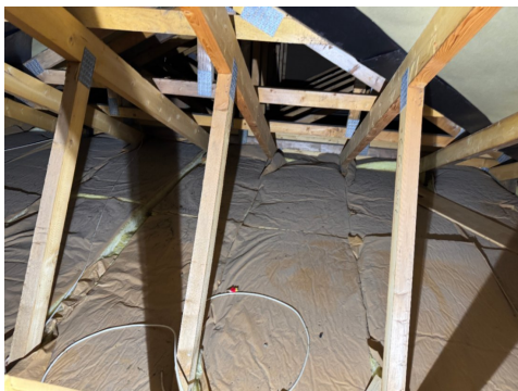
Eksempel på manglende lufting ved raft
