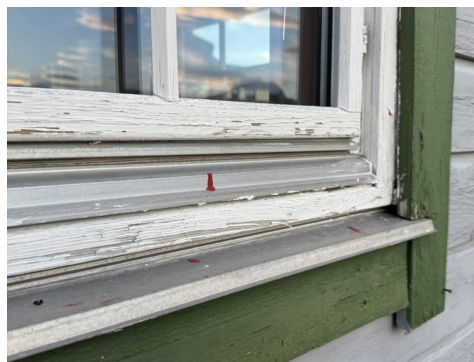
Eksempel på manglende åpning mellom beslag og bordkledning/ omrammingsbord
