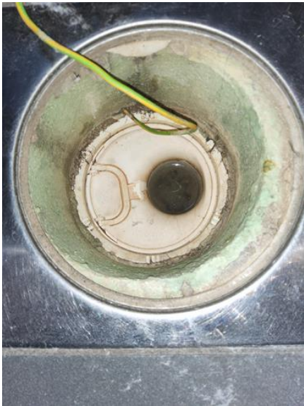
Våtrom - [Sluk bad 2]
