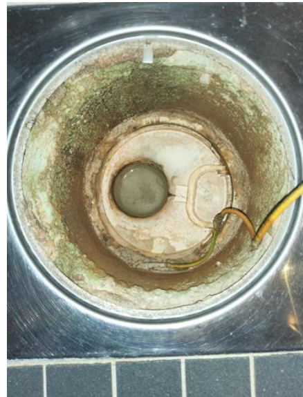
Våtrom - [Sluk bad 1]
