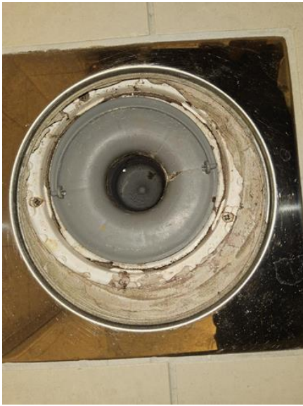
Våtrom - [Sluk bad.]
