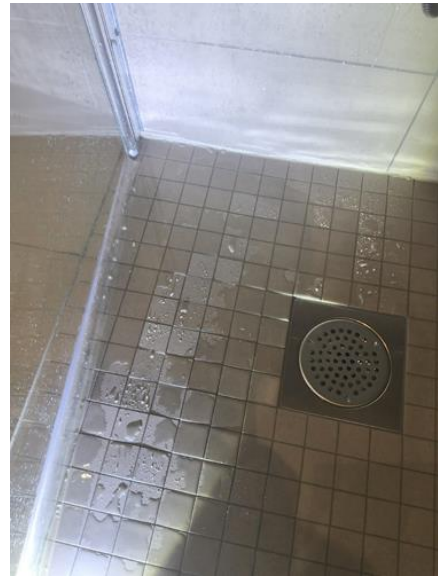
Fallforhold (gulv) - [Fallforholdet i dusjsonen ]
