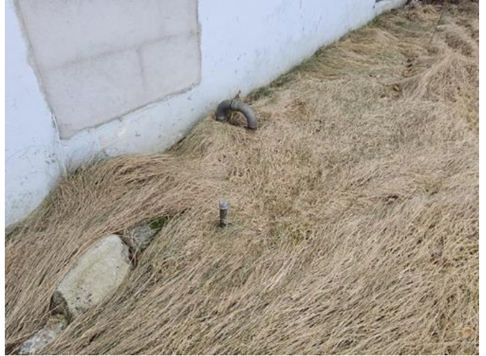
Stikkledninger og tanker - [Spor etter nedgravd oljetank.]
