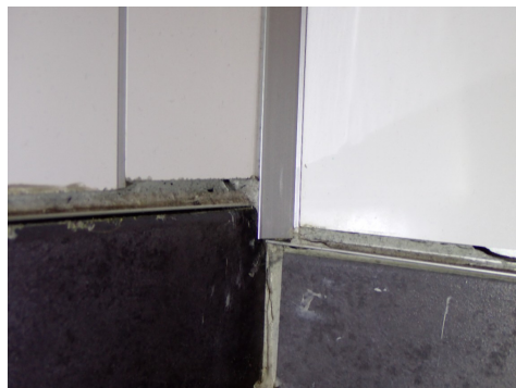
Trapping av plater i hjørne
