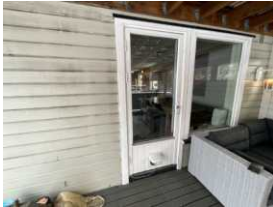
Balkongdør fra byggeår.
