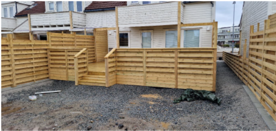
Valg 1_ Standard terrasse med smaltrapp og rekkverk
