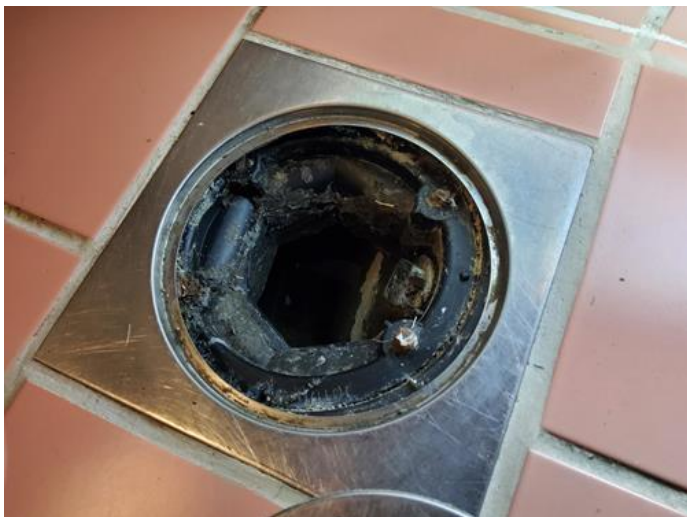
Membran, tettesjikt og overgang til sluk. - [Sluk ved badekar, bad 1. etg.]
