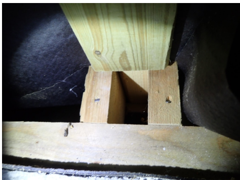
Eksempel på opplagring av bjelker (under stua)
