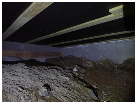
Fra krypekjeller (del mot nordvest)
