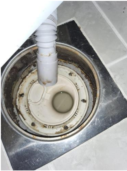
Våtrom - [Sluk bad 1 1.etasje ]
