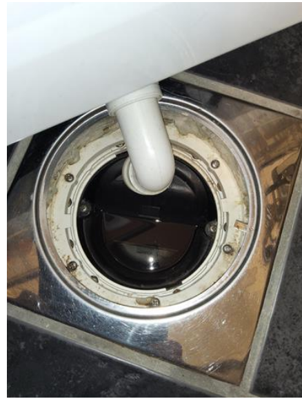
Våtrom - [Sluk bad 2 1.etasje ]
