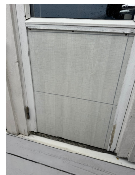
Balkong dør med utv vær slitasje
