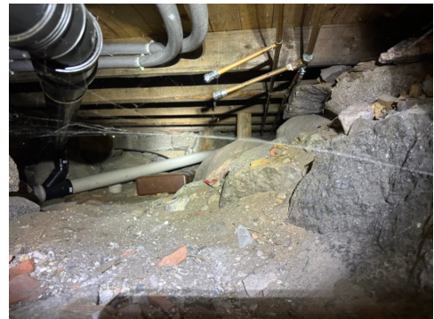
Kryperom med tilgang fra kjeller.
