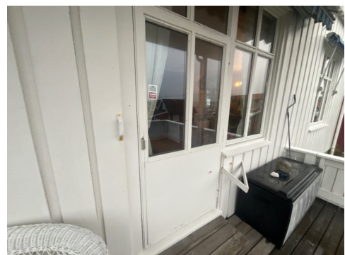
Balkong dør med utv vær slitasje
