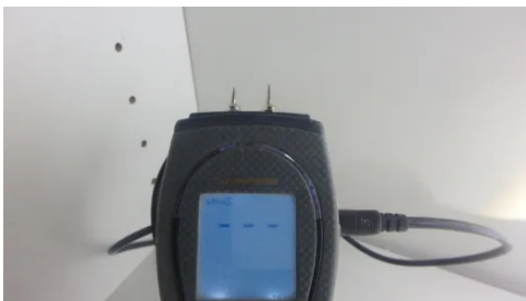
Fuktmåling i vegg til bad fra tilliggende soverom.
