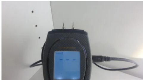
Fuktmåling i vegg til bad fra tiliggende soverom.
