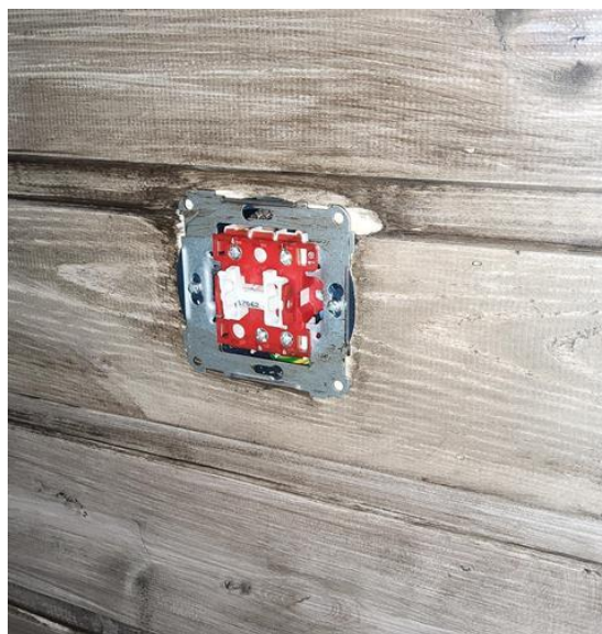
Forenklet vurdering av det elektriske anlegget - [Bryter men manglende deksel]
