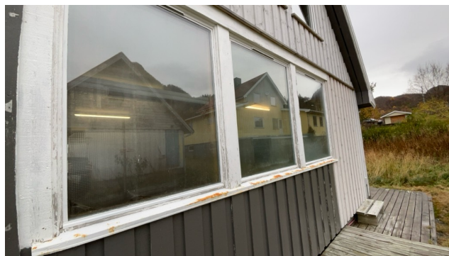
Utsnitt av vinduer.
