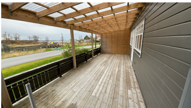
Utsnitt av terrasseareal ved fasade mot sørvest.
