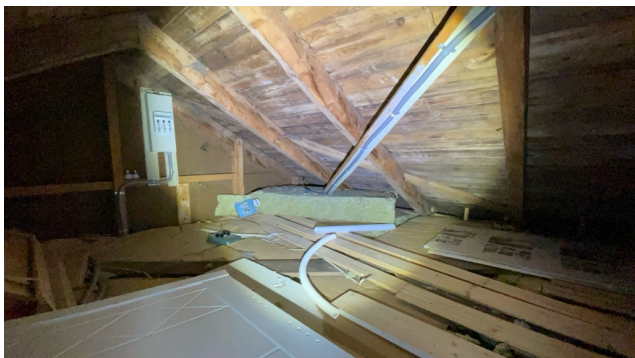
Utsnitt av takkonstruksjoner.
