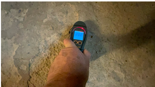
Måling på gulvflate.
