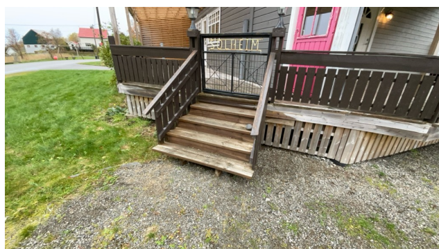
trapp til terrasse ved fasade mot sørvest.
