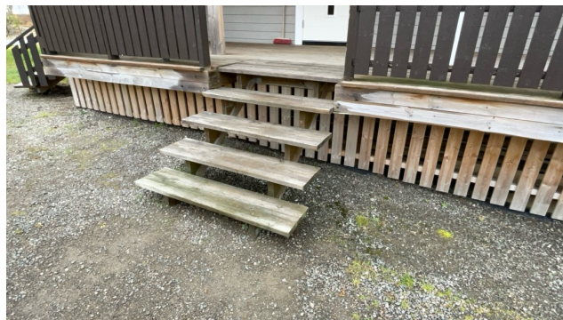
Trapp ved inngang.
