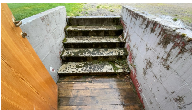
Trapp fra terreng til kjeller.
