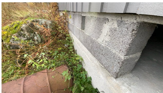
Åpning i ringmur i fasade mot nordøst.
