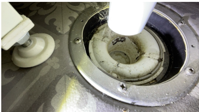
Sluk med gulvbelegg avsluttet under klemring.
