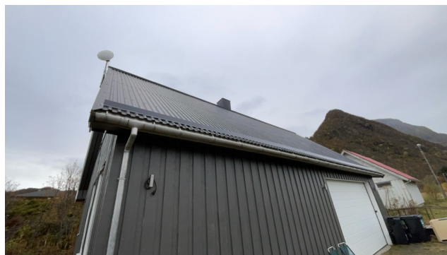
Takrenner og -nedløp av metall.
