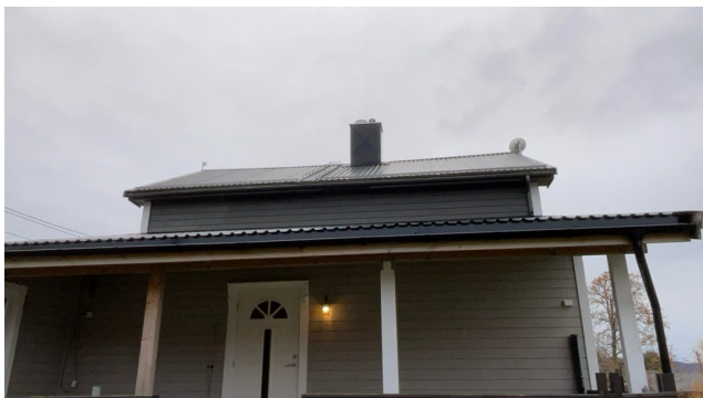
Takstige og snøfanger på hovedtak ved side mot sørøst.
