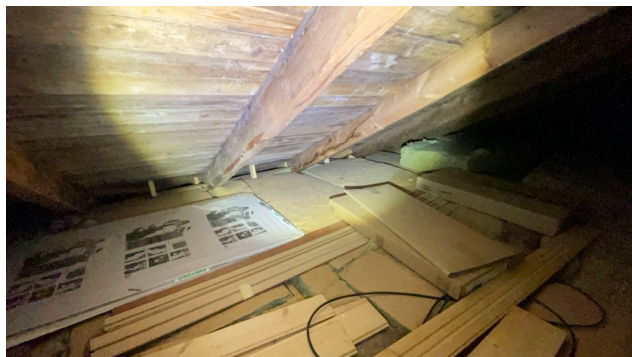
Utsnitt av takkonstruksjoner.
