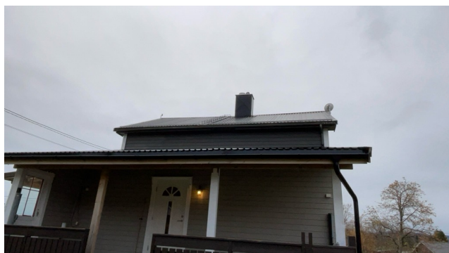
Takflate mot sørøst.
