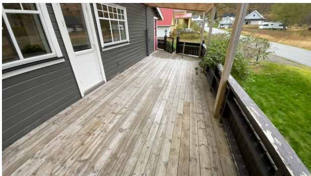
Utsnitt av terrasseareal ved fasade mot sørvest.
