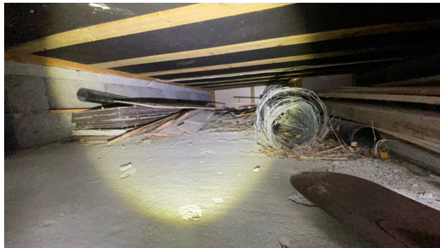
Utsnitt av kryperom sett fra åpning i ringmur.
