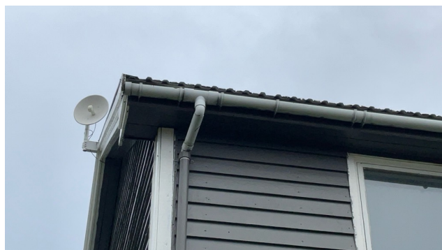
Takrenne og -nedløp ved fasade mot nordvest.
