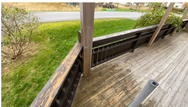
Utsnitt av terrasseareal ved fasade mot sørvest.
