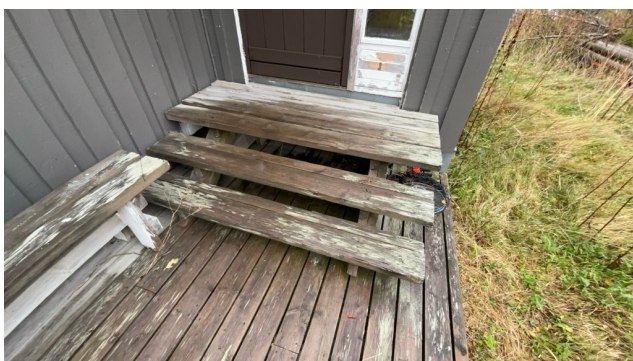
Trapp ved inngang..
