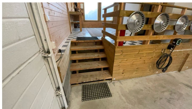
Trapp mellom garasjeareal og hovedplan (oppholdsareal).
