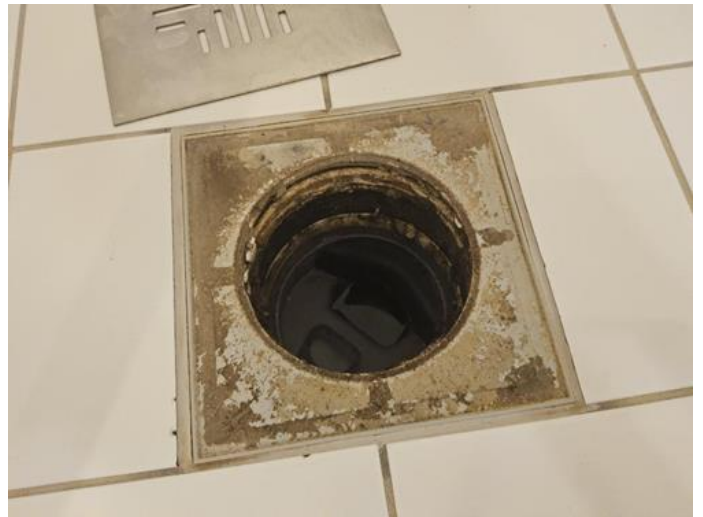
Våtrom - [Sluk på bad 1.etg. ]
