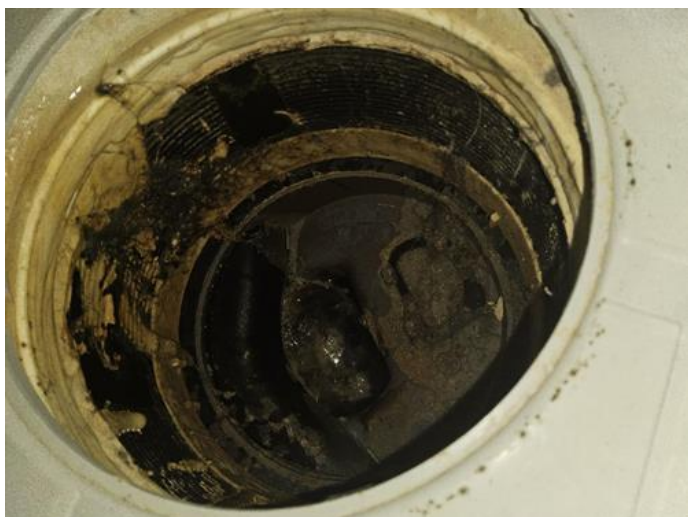
Våtrom - [Sluk på bad 3.etg (under dusjkabinett).]
