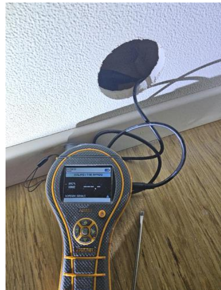
Våtrom - [Fuktmåling bad 1.etg. ]
