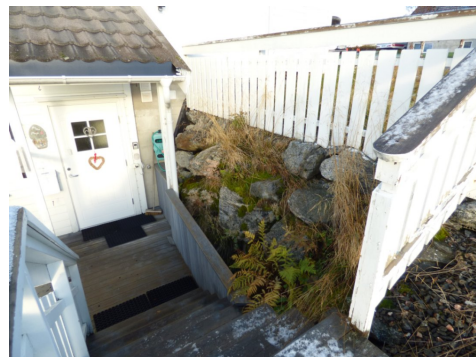
Forstøtningsmur i stein
