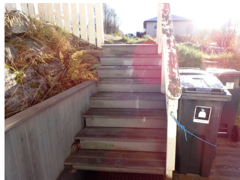
Trapp fra innkjørsel til område ved inngang
