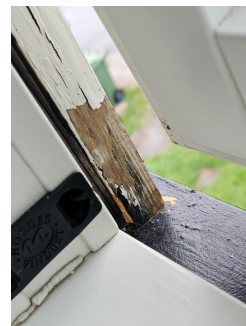
Omramming lagt ned på vannbrettet har ført til fuktopptak og påbegynte fuktskader.
