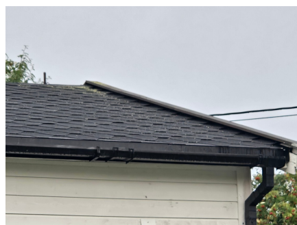
Mosevekst på takoverflaten mot nord.
