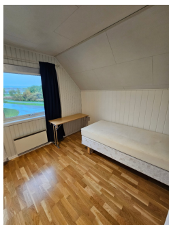
Sovrom mot nord i 2. etasjen har ingen løsning for ventiler.
