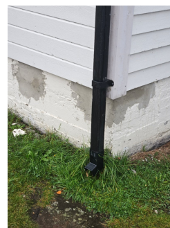
Områder hvor eier har utbedret sprekkdannelser i grunnmuren.
