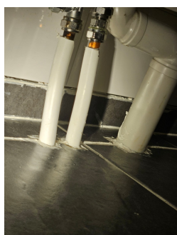
Rørgjennomføringer i gulv (våtsone).
