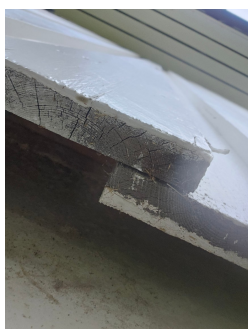
Endaved er ikke overflatebehandlet.
