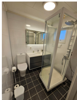
Oversiktsbilde med framtrekt dusjkabinett.
