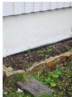
Synlig fuksikring av grunnmur med plast.
