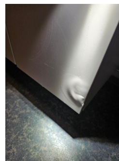
Svelling i baderomsinnredning.
