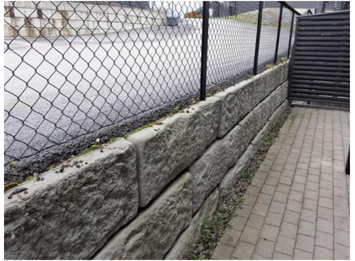
Utvendig - [Støttemur mellom gårdsplass og inngang]
