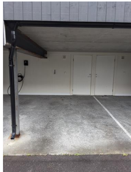
Utvendig - [Carport med bod i bakkant]
