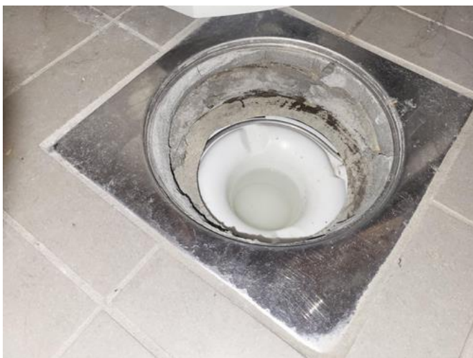
Våtrom - [Sluk vaskerom]
