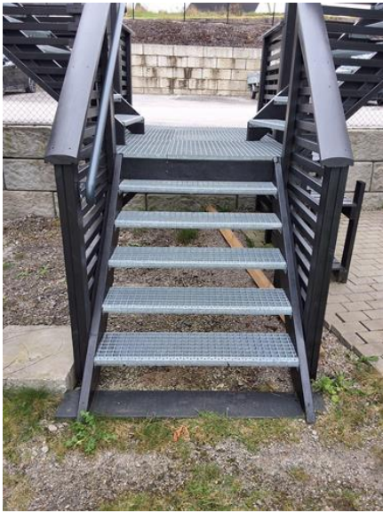
Utvendig - [Felles utvendig trapp]
