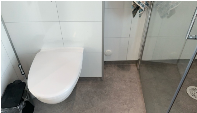
Avrenning fra vannskap.
