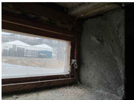
Det er et kobla vindu i kjeller
