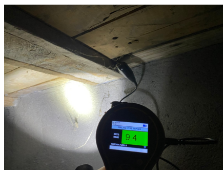
Fuktsøk i himling i kryp kjeller=ok
