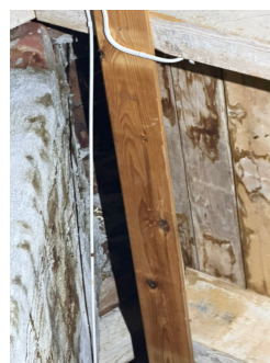
Fuktsøk på ene rommet i 2 etasje = ok, med fuktmerker langs pipe
