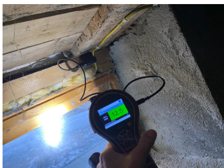
Fuktsøk i himling i kryp kjeller=ok
