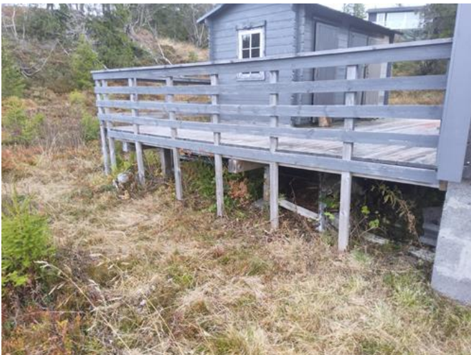
Utkragede eller understøttede konstruksjoner (balkonger, verandaer) - [Balkong mot nord.]
