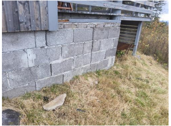
Grunnmur - [Grunnmur sydvestre hjørne.]
