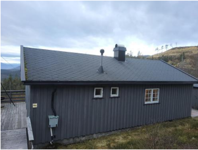
Tekking (undertak, lekter og yttertekking) - [Yttertaket. ]
