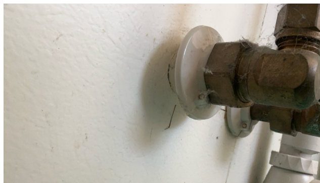
sprekk mellom fuge og belegg til vann installasjonen
