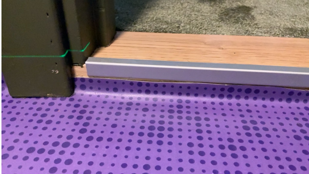
laveste kant på membran til toppen av slukriaten er målt til 45mm
