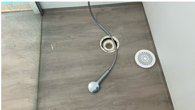
inedlags feltet renner vann i sluk
