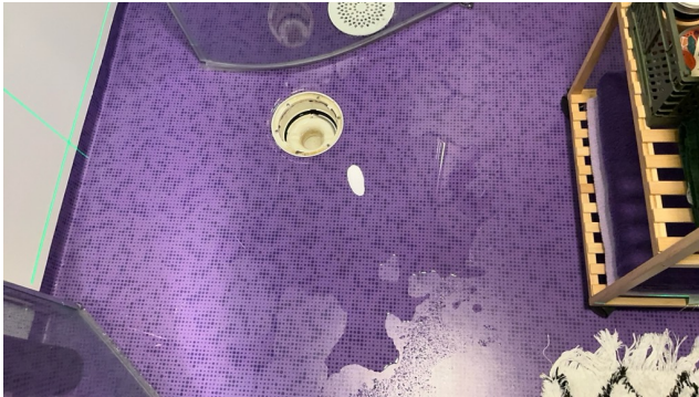
laveste kant på membran til toppen av slukriaten er målt til 45mm
