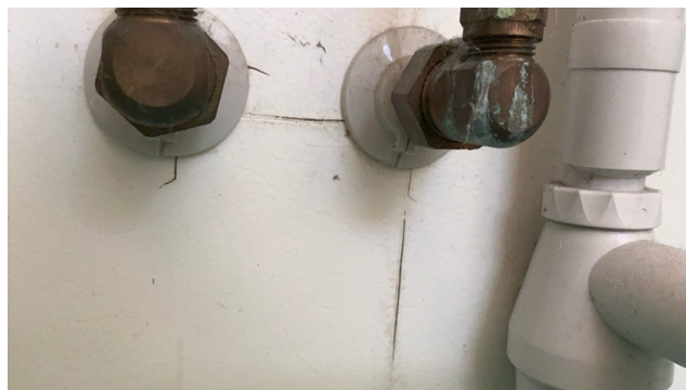
sprekk mellom fuge og belegg til vann installasjonen
