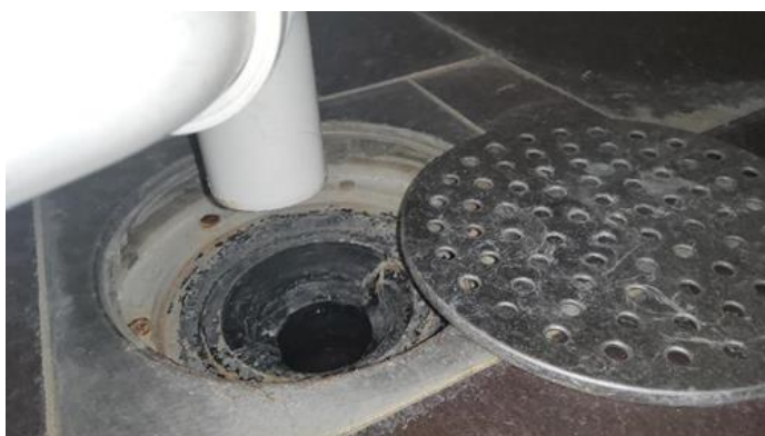
Membran, tettesjikt og overgang til sluk. - [Sluk 2 bad 1]
