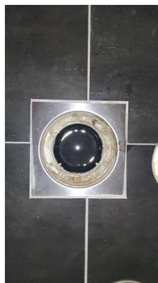
Membran, tettesjikt og overgang til sluk. - [Sluk bad 2]
