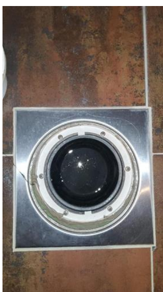
Membran, tettesjikt og overgang til sluk. - [Sluk bad 3]
