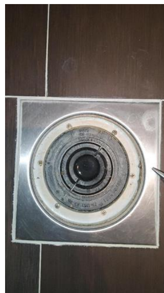
Membran, tettesjikt og overgang til sluk. - [Sluk 1 bad 1]
