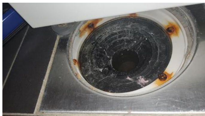
Membran, tettesjikt og overgang til sluk. - [Sluk vaskerom]
